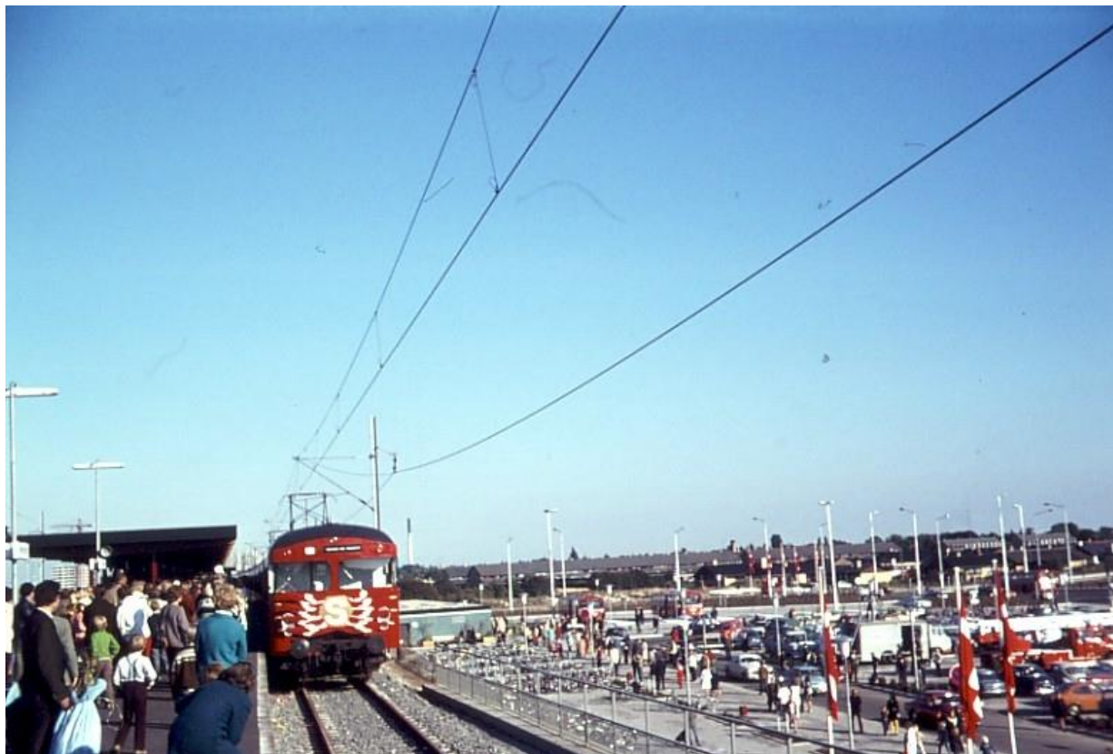
Så kom det endelig! Indvielse af S-banen til Vallensbæk i efteråret 1972. Køge Bugt-planlægningsudvalget havde allerede fire år før fremlagt sin dispositionsplan for området, og forlængelsen af S-banen ned langs bugten fik et betydeligt efterslæb i forhold til den forstadsudbygning, der fandt sted i forhold til planen. 10
