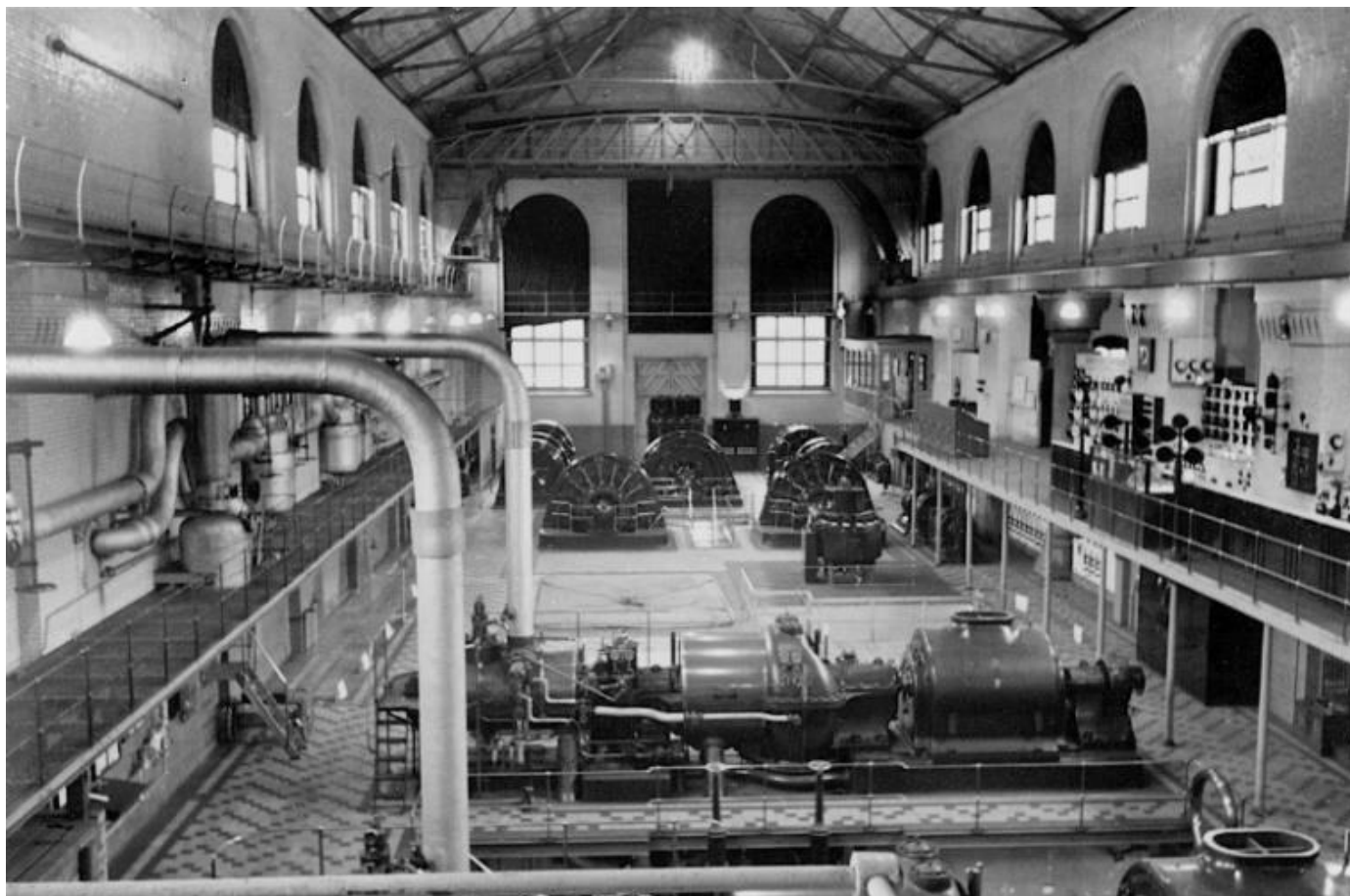
Maskinhal på Østre Elektricitetsværk på Københavns Østerbro i 1941 (Københavns Stadsarkiv)
