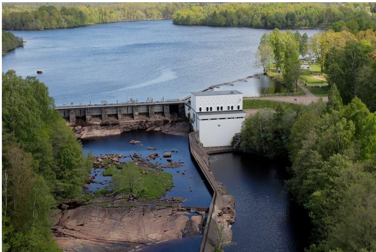
Et nyt vandkraftværk i Majenfors afløste omkring 1950 et ældre fra 1908
