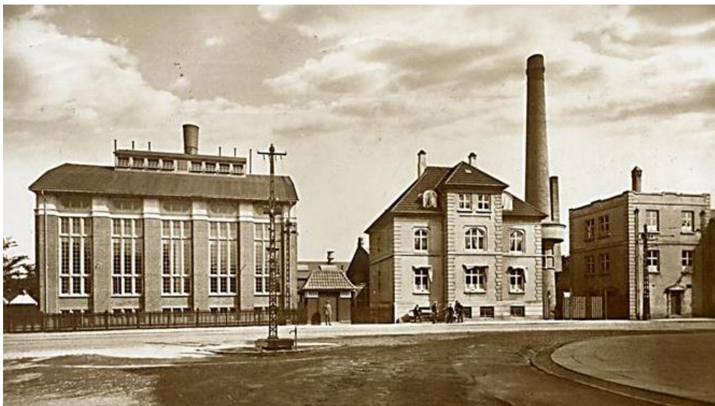
Skovshoved Elektricitetsværk (Gentofte Lokalhistoriske Arkiv)
