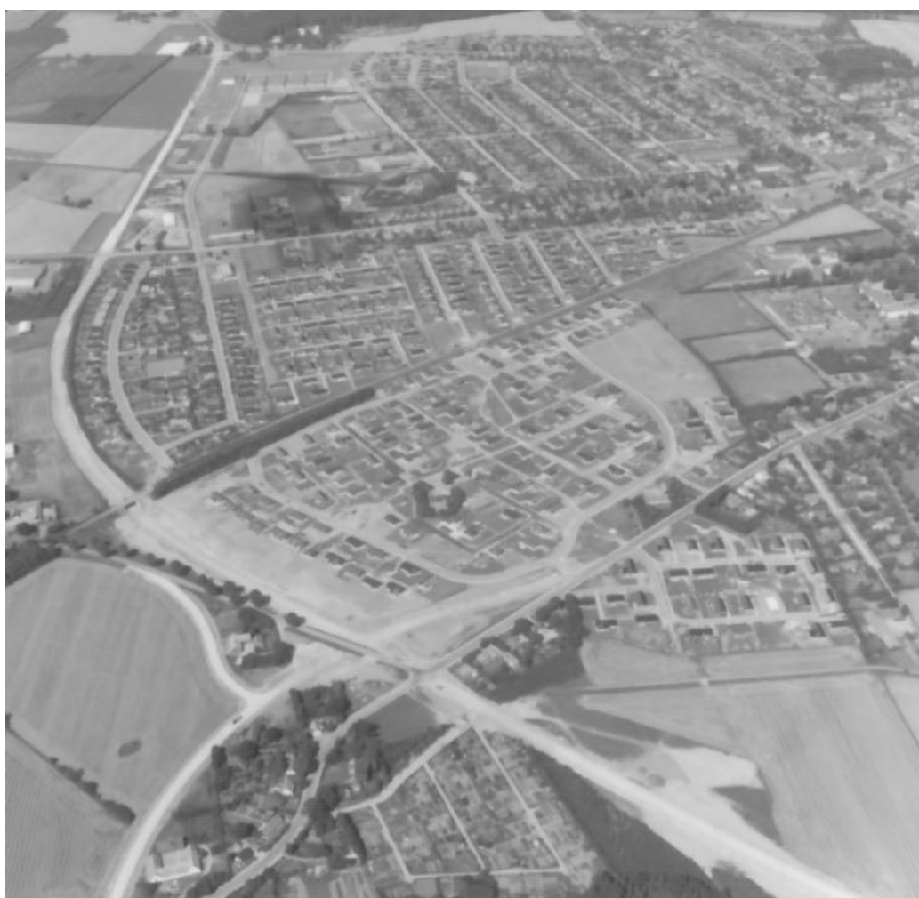
Et andet af Haslev store parcelhuskvarterer i 1977. Her det, der opstod på begge sider af den gennemgåede banelinje i midten af billedet. Ringvejen vest om byen, der førte til Sydmotorvejen ved Ulse, ses under anlæg. Kvarteret Vestparken ses på den øverste halvdel af billedet 131
