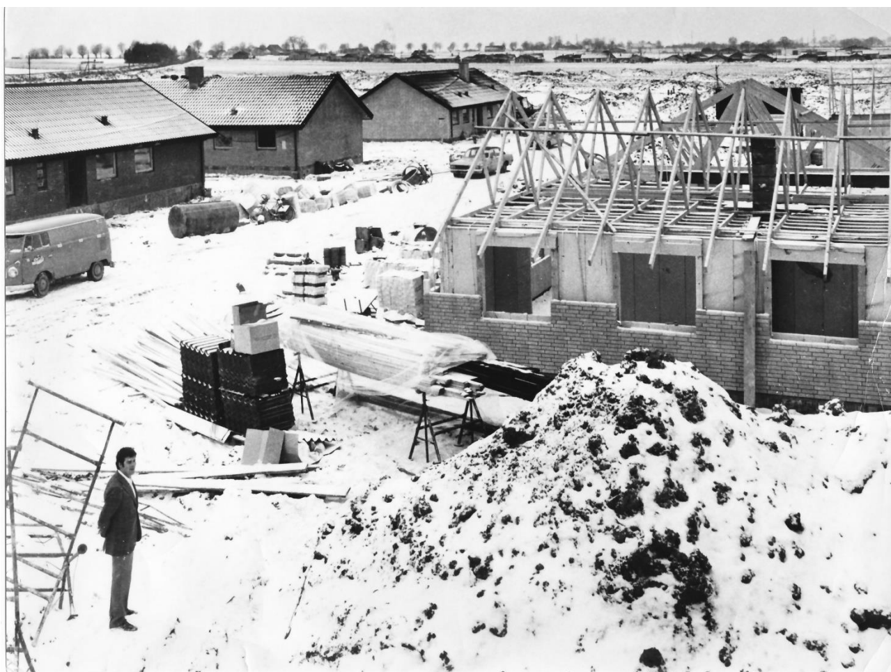
O.C. Huse under opførelse i Vestparken 1972. Klassisk elementtypehusbyggeri med præfabrikerede bærende betonelementer og tagkonstruktioner og med ydre skalmuring. 135
