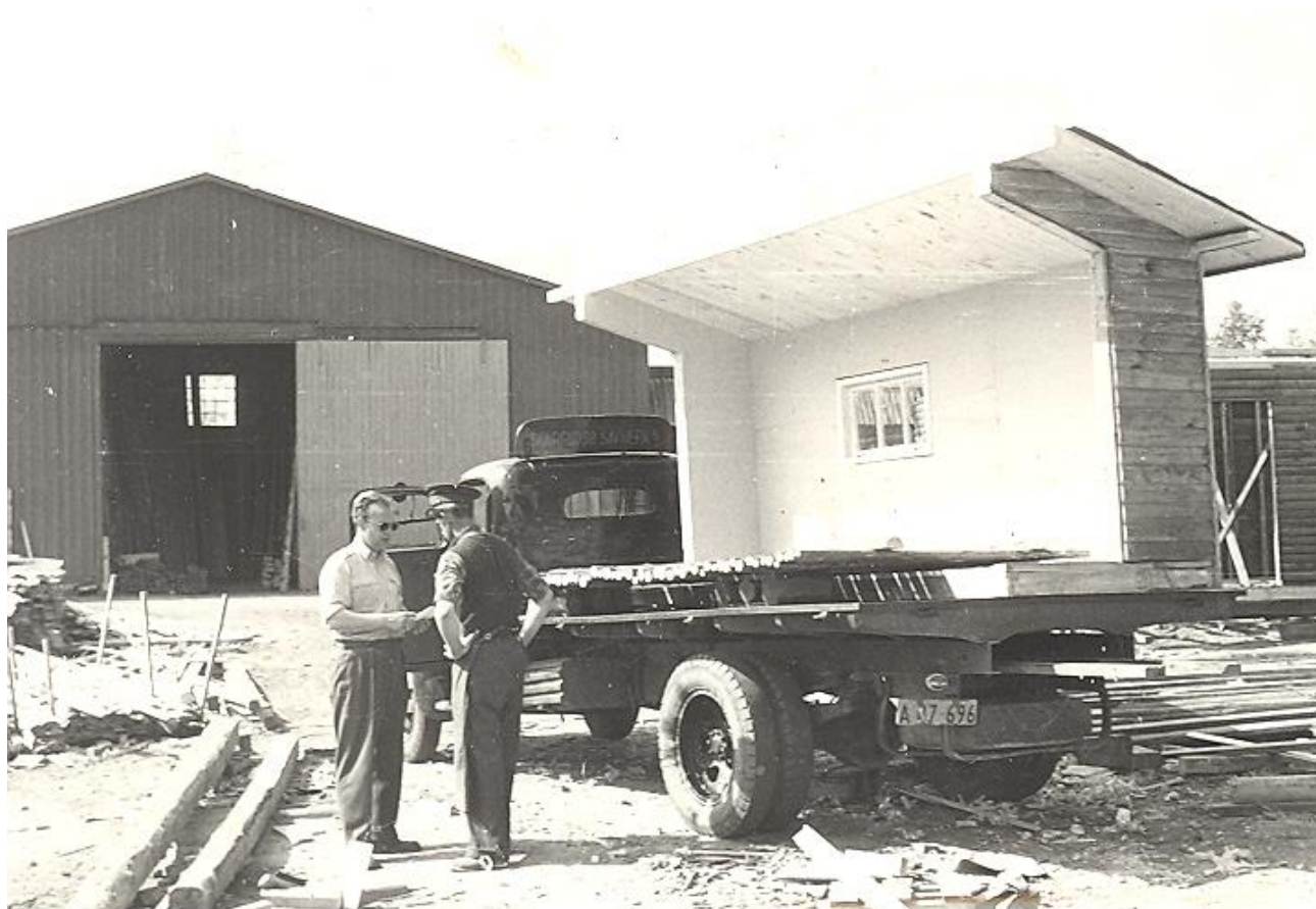
Når typesommerhusfirmaerne skulle levere større sommerhuse, blev disse delelementer fremstillet på virksomhedernes produktionsområde for stykvisst at blive kørt ud til kundens sommerhusgrund. Her er vognen fra Skarridsø Savværk på vej ud med et delelement til et nyt Skarridsø Hus i begyndelsen af 50'erne (Holbæk Arkiverne, Jyderup Afdeling).
