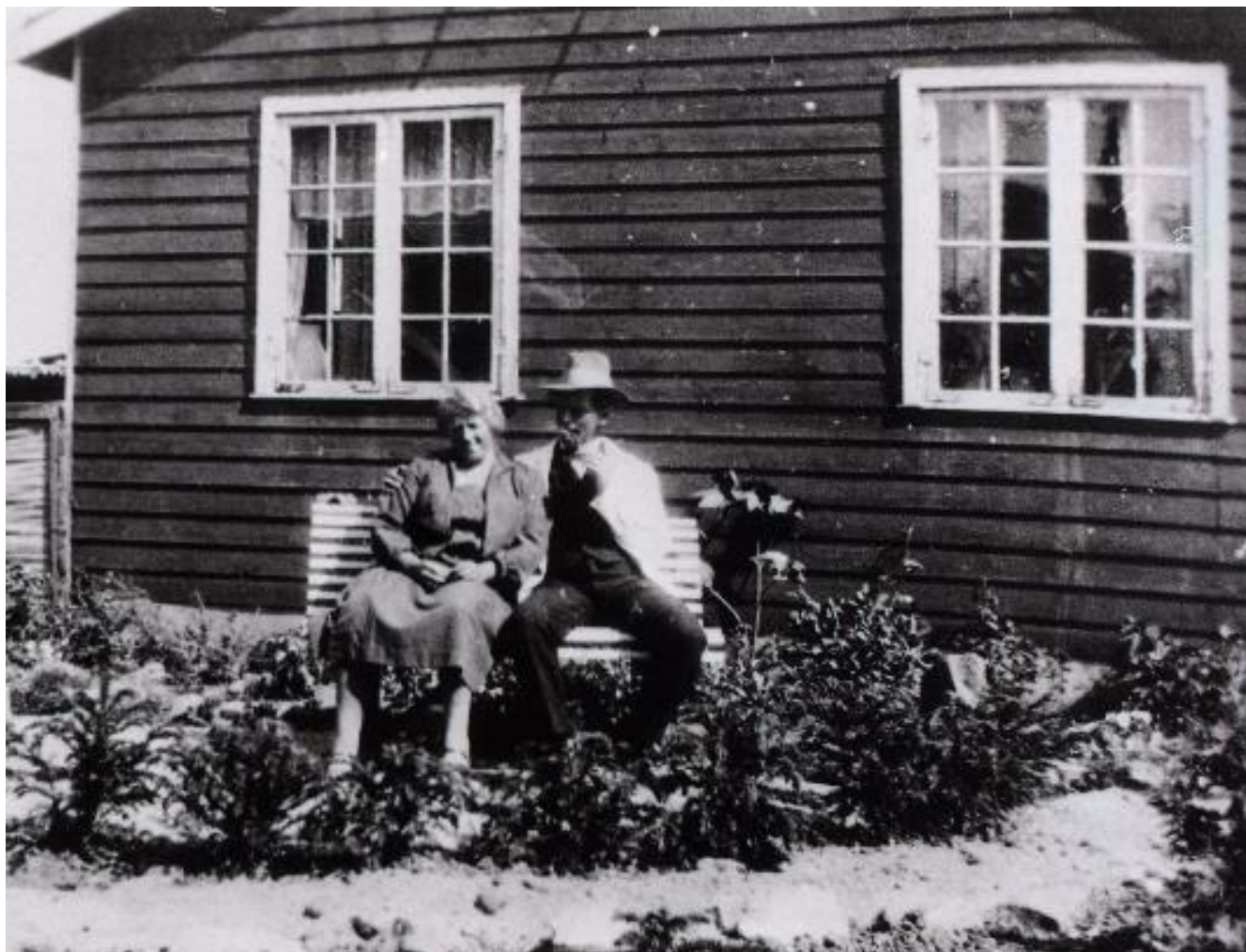
Småt, men godt. En varm sommerdag nydes i sommerhusbyen ved Ishøj Strand en gang i 30'erne. På nær enkelte undtagelser nåede sommerhusene i Køge Bugt sommerhusbybælte i størrelse og indretning i mellemkrigstiden og 40'erne ikke i nærheden hovedstadsoverklassens prætentiose sommerhuse og- villaer ved Kattegat. Til gengæld gav Køge Bugt mulighed for, at et noget bredere samfundslag kunne opnå det gode, som et sommerhus udgjorde. Sammen med områdets lejrklubber, telt- og hyttepladser, feriehem, kroer og traktørsteder blev Køge Bugt den jævne mands sommerland. Ligesom hovedstadens forskellige bydele og hovedstadsmetropolens forstæderne blev stærkt socialt segregeret, gjaldt det også dens sommerland. (Ishøj Lokalhistoriske Arkiv)
