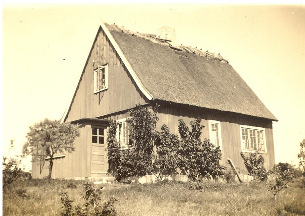
Kulhuses første sommervilla, Udkig, opført i 1918. Det efterfølge sommerhusbyggeri blev langt mere beskedent. (Frederikssund Stadsarkiv)
