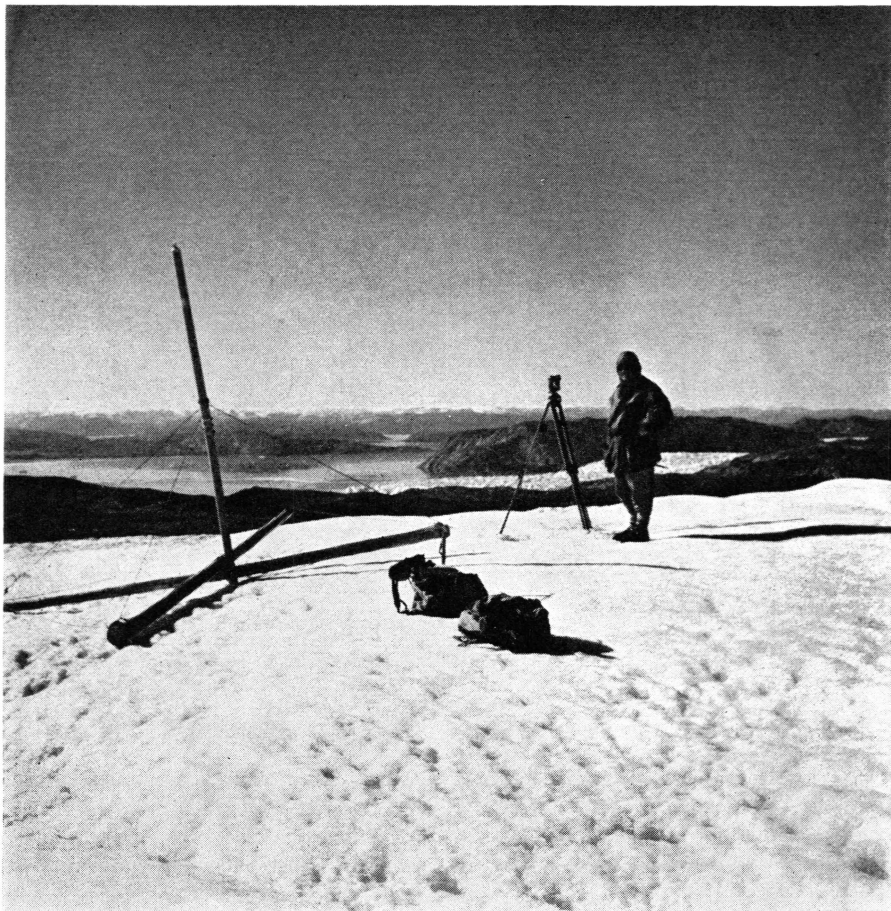
Photo 8. Théodolite centré sur B 21, signal déplacé pendant le tour d'horizon.
