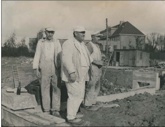
Tre murere foran fundamentet til bogtårnet. I baggrunden Statens Gymnastikinstitut fra 1922, som i dag huser Institut for Idræt og Ernæring under Københavns Universitet.
