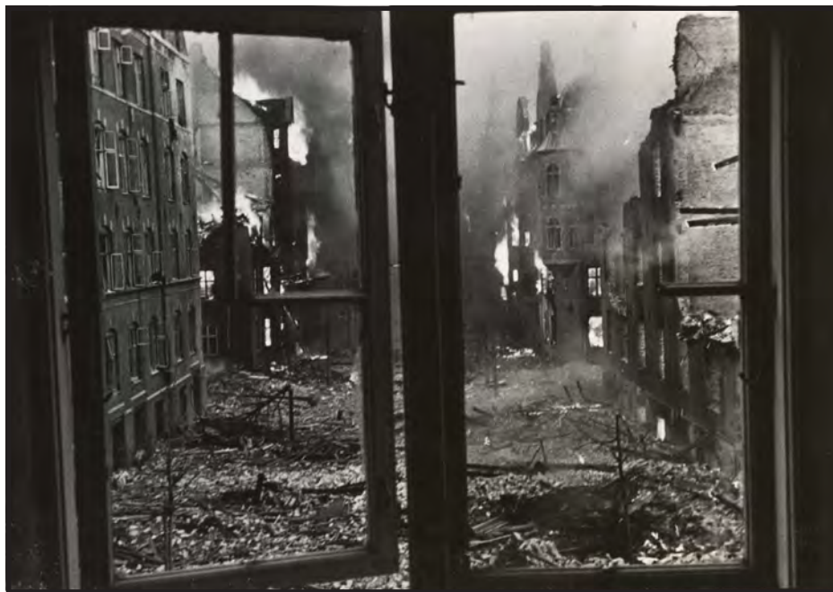
Kvarteret ved den franske skole fotograferet gennem et vindue efter det engelske bombardement (Dagbogen s. 69.298).
