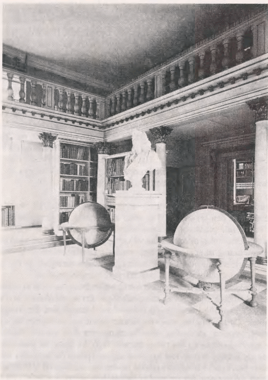
Frederik 3.s bibliotekssal. De 3 synbare søjler for enden af salen (overbibliotekarens kontor skimtes til højre) har oprindeligt været rødbrunt marmorerede med sorte og hvide indslag, det samme gælder mæglerspejlene ovenover (hjørnemægleren over hjørnesøjlen ses tydeligt). Søjlen til venstre, den første på langsiden, har været grøngrå marmorerede med sorte og okker indslag som mæglerspejlet ovenover. De buttede ballustre på galleriet var sortmarmorerede med hvide indslag. (Ballustrene i den lille sal er slankere, se ovenfor s. 44). Galleriets håndfang, mæglerrammer og gesims var ensfarvet hvidgrå, mens konsoller, lister, søjlekapitæler og søjlebaser var forgyldte. Busten af Frederik 3. står i dag i bunden af Læsesalen, globerne i Kort- og Billedafdelingen.
