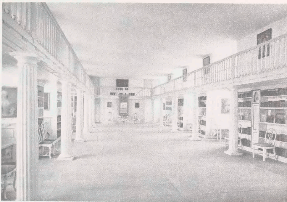
Bibliotekssalen på Koldinghus, rejst ved genbrug af J.H. Kochs søjler og gelænderværk fra salene i det tidligere kunstammerareal.
