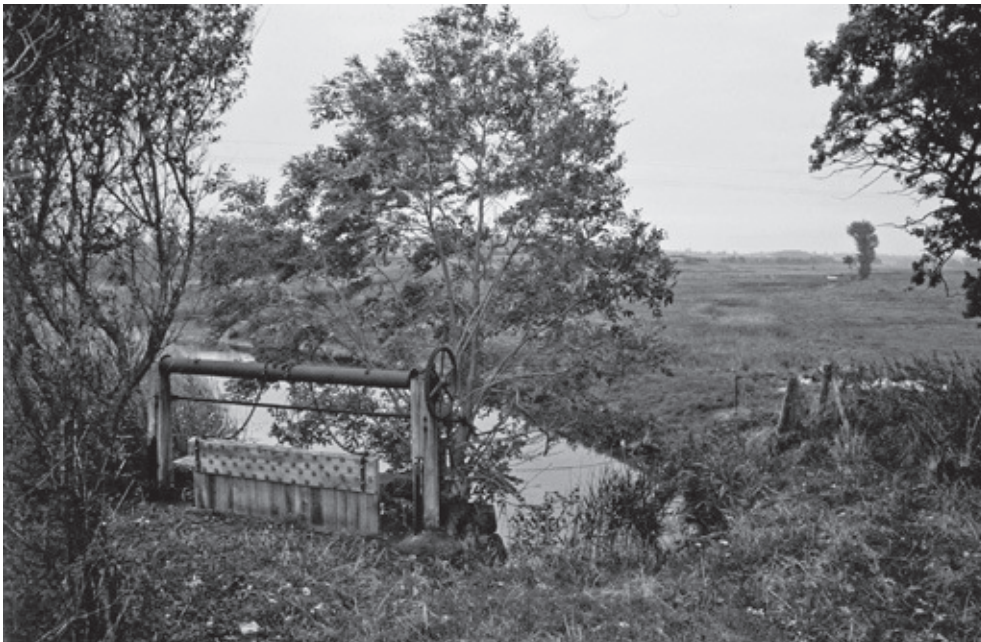
Figur 21. Føns Vang på Vestfyn. Fjorden blev inddæmmet omkring 1790 af Wedellsborg gods. I forgrunden ses stibordet ved nordre landkanal. Ved fjordmundingen udenfor billedet anlagdes i 1850'erne en udskibningshavn til landbrugsprodukter, og på vejdæmningen over fjorden opførtes én af landets første damppumper til at tørholde arealet om sommeren. Siden fotooptagelsen er vandstanden hævet og det meste af arealet er oversvømmet. Foto: Morten Stenak 2002.
