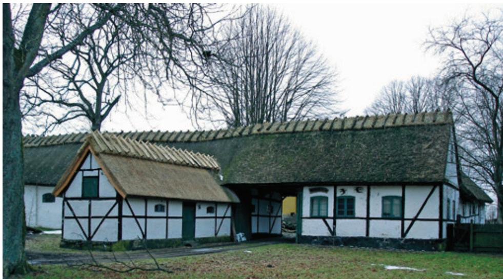
Fig. 4. Peder Madsens halvgård i Dramstrup har, som den eneste i byen, i hovedtræk stadig sit udseende fra da den blev bygget i 1777. Foto: Martin Bork, 2006.
