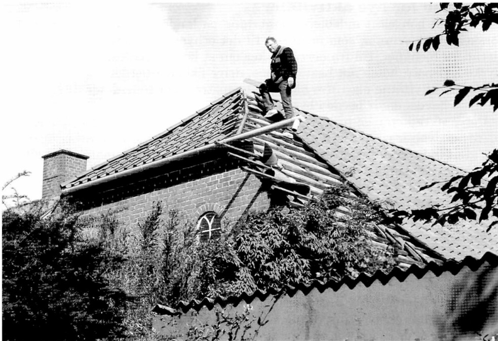
Fig. 4.6. Carsten Lundhøj i færd med omlægning af taget på udhyslængen, som nu er under reparation og ombygning, efter at man i de første år siden overtagelsen har arbejdet med indretningen af stuehuset. Foto: Gunnar Solvang, 1998.
