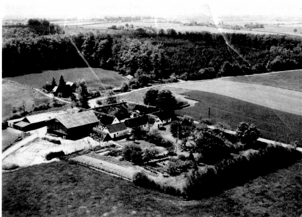
Fig. 1. Forfatterens fødegård bestående af den oprindelige 1700-tals stråttækte firlængede gård med stuehus og stalde til heste køer og grise, der i 1900-tallet var udbygget med staklade og fritliggende hønse- og maskinhuse og omgivet med stor køkkenhave til husholdningens forsyning med grøntsager og bærfrugt. Foto Sylvest Jensen omkring 1950. Privat.
