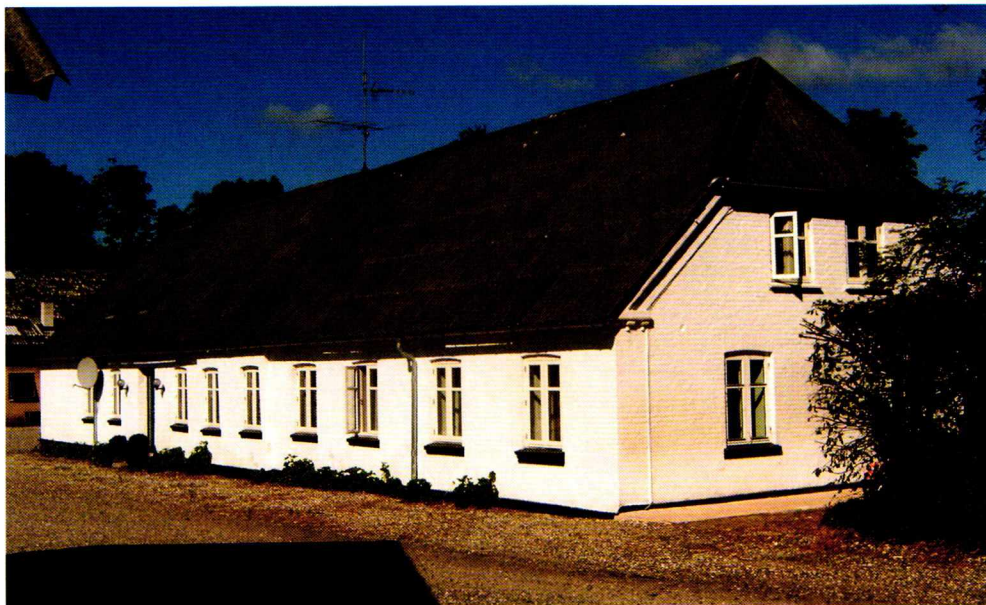
Fig. 16: Torndals stuehus i dag. Huset er hvidkalket, flere døre er blevet sløjfet, kvisten er fjernet og eternit har afløst strå efter en nedstyrtning under en ombygning af stuehuset. Hovedstrukturen, grundmuren, er dog ikke ændret siden Lausts ombygning. Foto: Peder Dam 2007.
