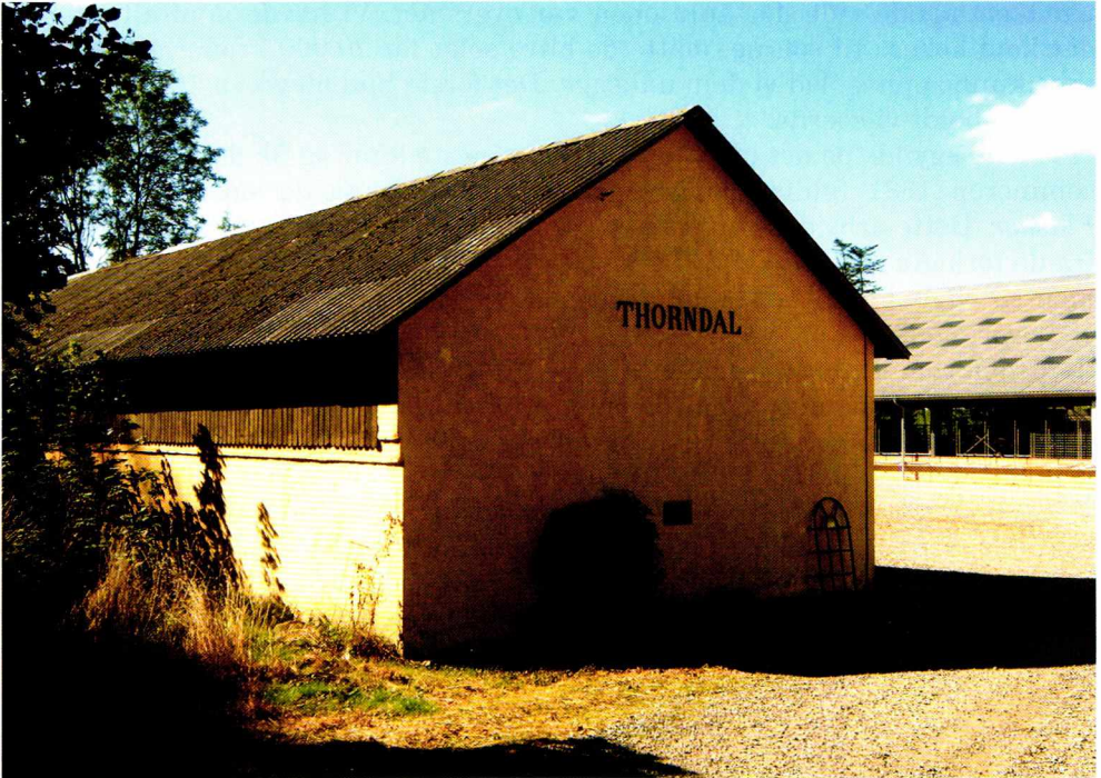
Fig. 12: Den eneste af Lausts nye staldbygninger, som stadig står i dag, er den østre staldbygning. Den blev opført i kampesten, men murene er i dag kalket over. Midt på gavlen ses mindestenen, som Laust også omtaler i teksten: "Bygget 1884. Morgenstund har guld i mund." Bag ved staldbygningen mod højre ses den moderne ungvægsstald. Foto: Peder Dam 2007.
