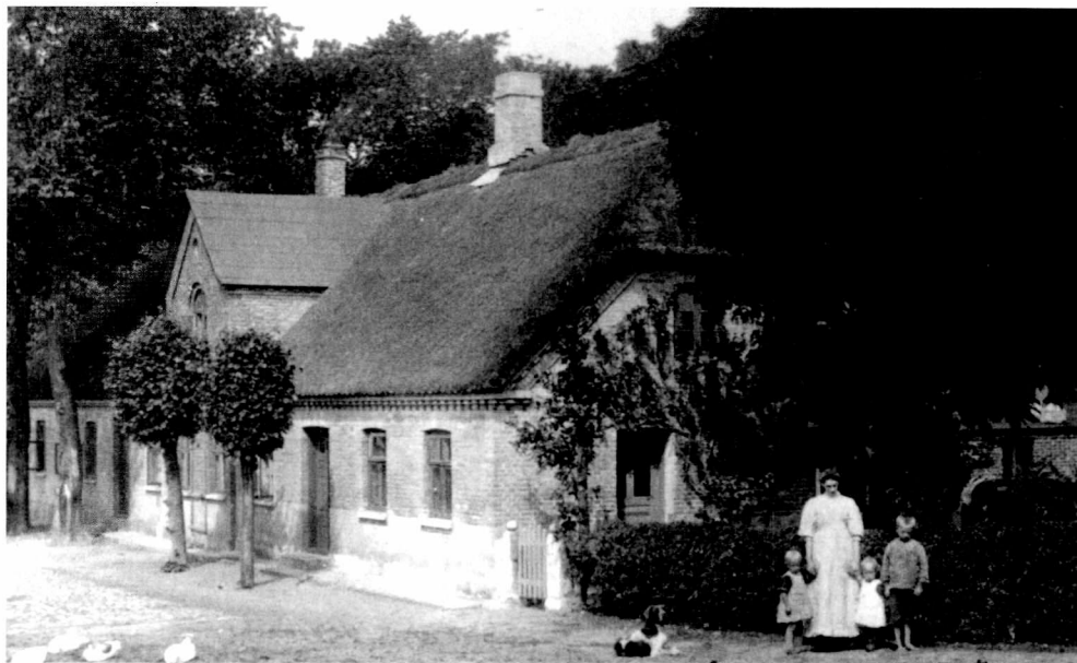
Fig. 15: Laura Binderup, yngste datter af Jensine og Laust Jensen, med børnene Dagmar, Christian og Ernst foran Torndals stuehus. Billedet må, ud fra børnenes alder, været taget omkring 1918, mens Laust stadig boede på gården som aftægtsmand. Stuehusets dimensioner blev ikke ændret nævneværdigt, siden Laust løftede tagkonstruktionen med donkraft, ravede murene ned og opførte nye ydre- og indemure 1884-85. Foto: Lokalthistorisk Arkiv Støving.
