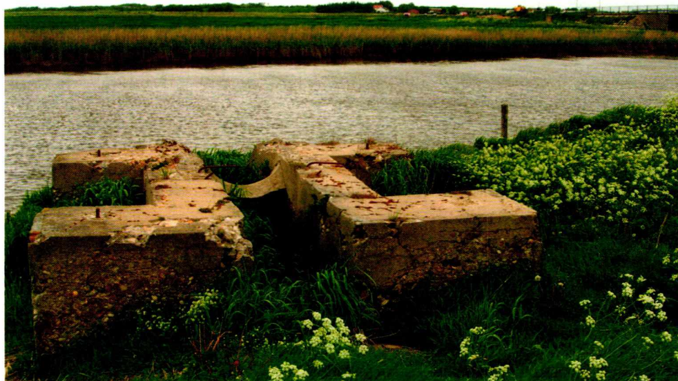
Fig. 13: Betonfundament til arkimedesskrue med vindmotor. Sneglen lå midt i funda- mentet, hvor den fra Varde Å trak vand op i en nu tilkastet kanal til Kravnsø Enge, Hostrup sogn. Jernboltene til mølletårnet ses stadig. Tarpbagebroen skimtes yderst til højre. Foto: Holger Villumsen 2005.
