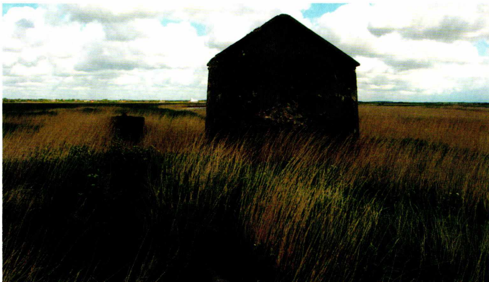
Fig. 15: På grænsen mellem Billum Enge og Janderup Enge byggedes dette motorhus af beton i 1917 til værn af en råoliemotor mod saltvand under vinteroversvømmelserne. Under Den 2. Verdenskrig erstattedes installationen af en elektromotor, der monteredes på soklen til venstre for huset. Fra soklen mod fotografen løb hovedkanalen mod Billum, på det første lille stykke i betonforet kant med lukkearrangement ved sognegrænsen. Åen løber højre om huset nedenfor brinken i højre side. Foto: Holger Villumsen 2005.
