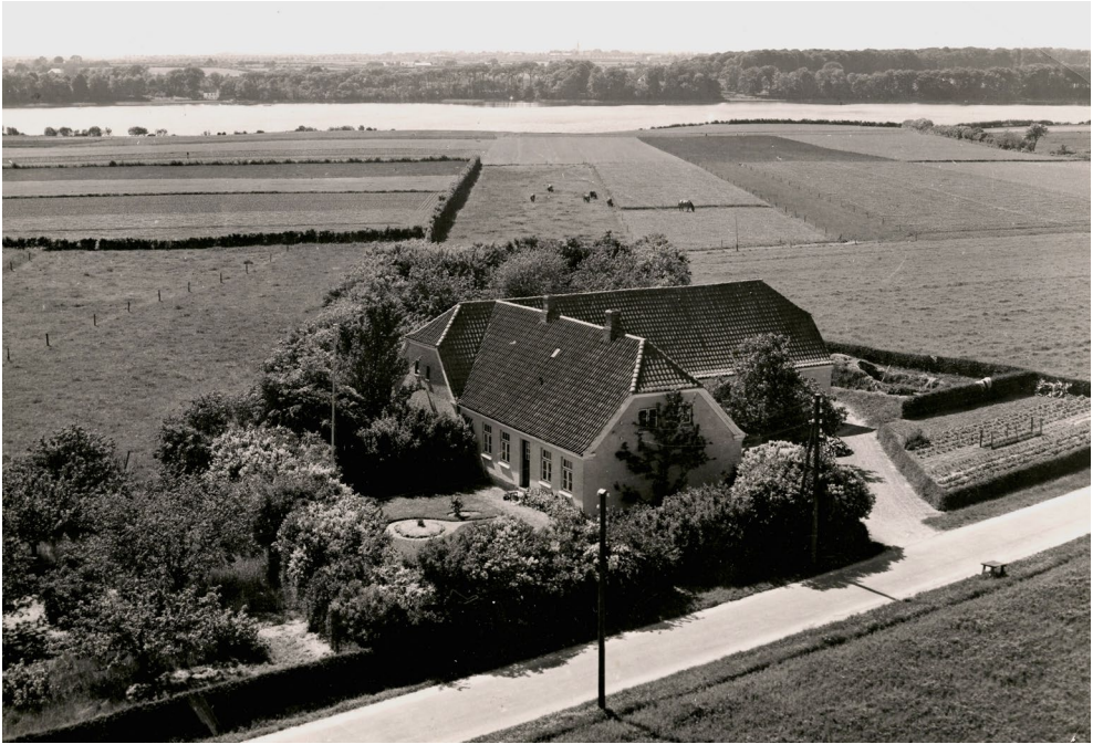
Figur 7. Statshusmandsbruget med de vinkelformede bygninger i Bedre Byggeskik stil, med køkken- og prydhave og bagved de udstrakte marker i tavlopdelte felter med heste og køer på græs. En sommerdag i 1953. Foto: Sylvest Jensen. GS-Arkiv.
