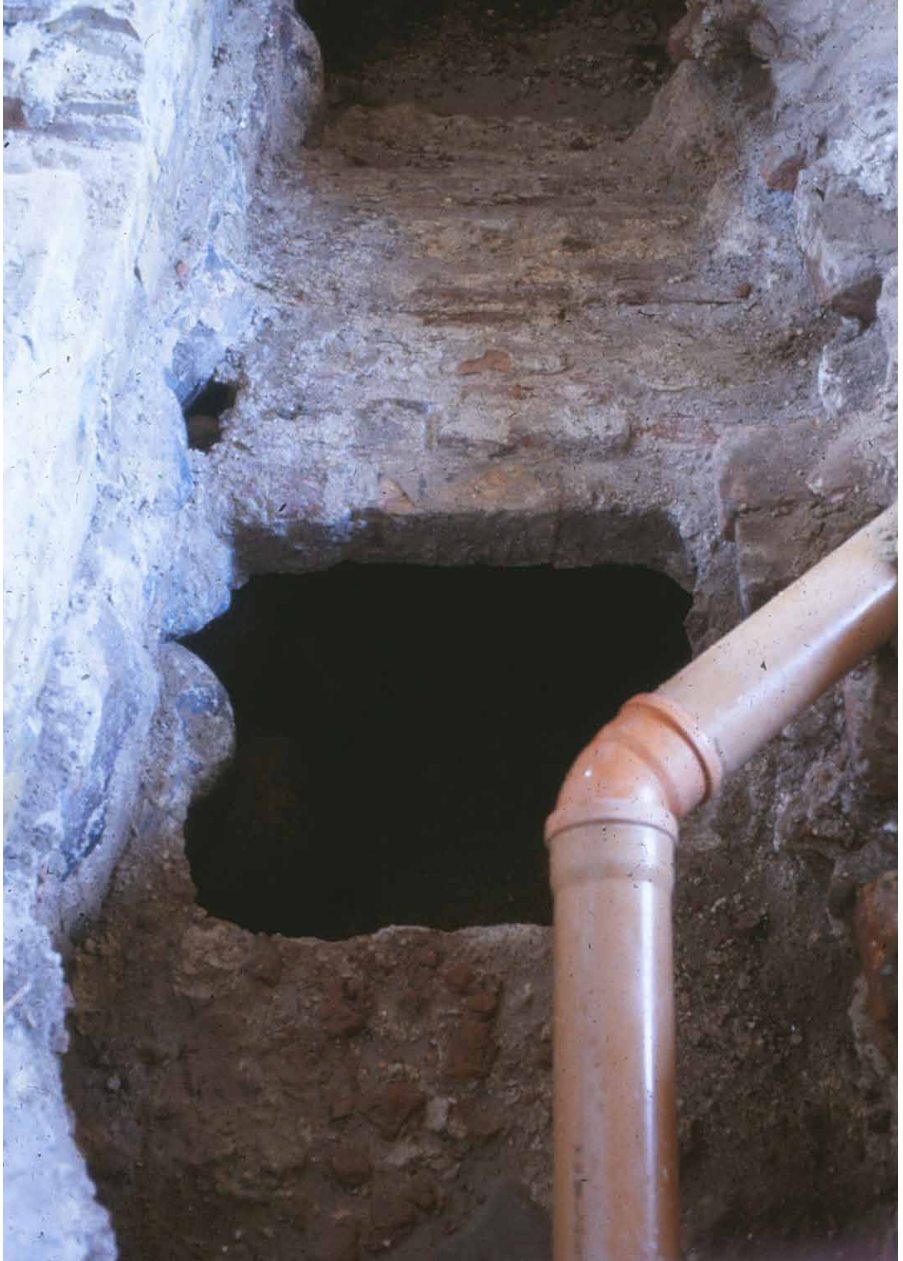
Figur 23. Hullet i latrinkulens hvælv. Foto: Jesper Hjerminde 1990.
