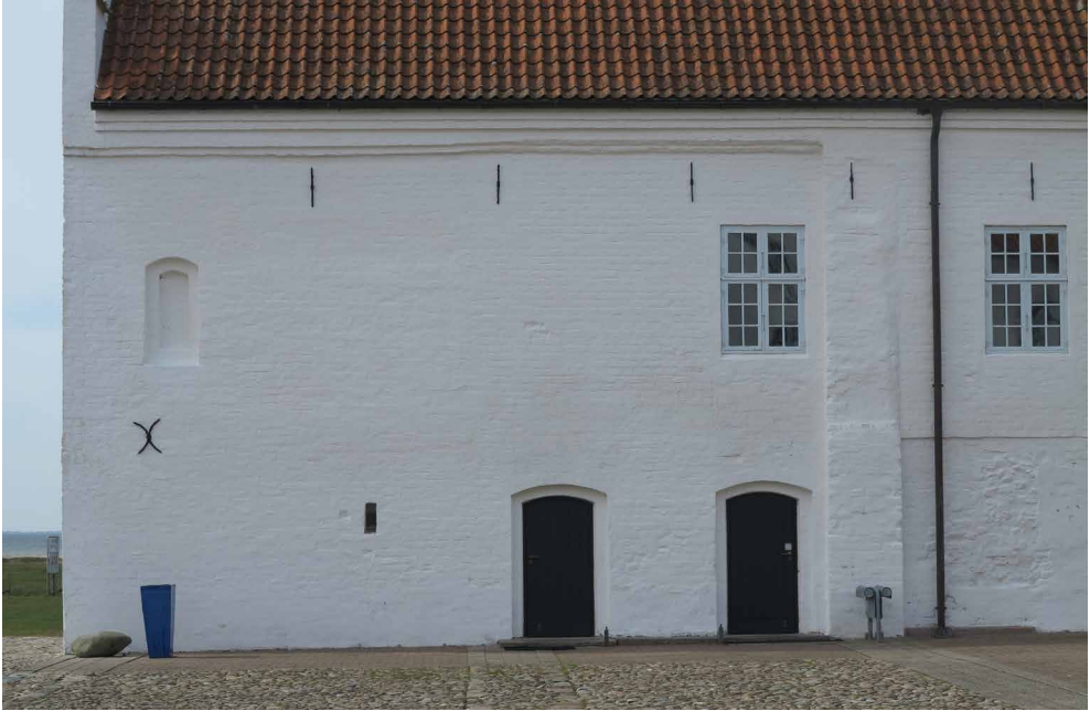
Figur 4. Søndre ende af vestfløjens gårdside. Sydfløjens vestre gavl uden gavltrekan- ten er indbygget i vestfløj, hvor den udgør søndre ende af vestfløjens facademur hen til murfremspringet. Det fladbuede vindue er oprindeligt i sydfløjens gavl. Foto: Jesper Hjermind 2014.
