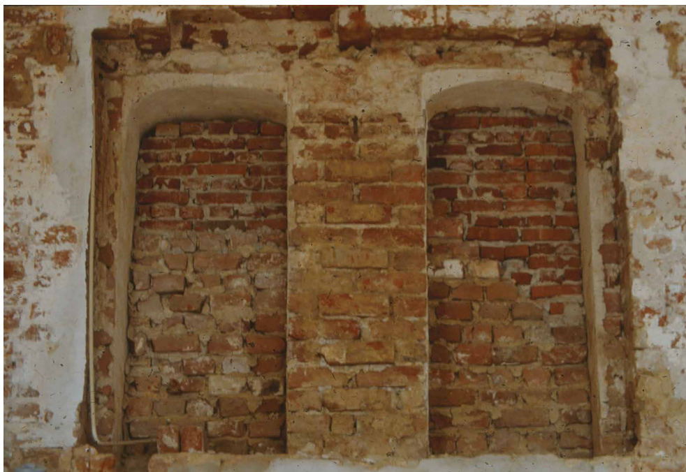
Figur 22. De to døre i nordfløjen ud til de to hemmeligheder uden på nordre ydermur. Mellem dørene ses en fortanding til en skillevæg. Foto: Jesper Hjerminde 1990.
