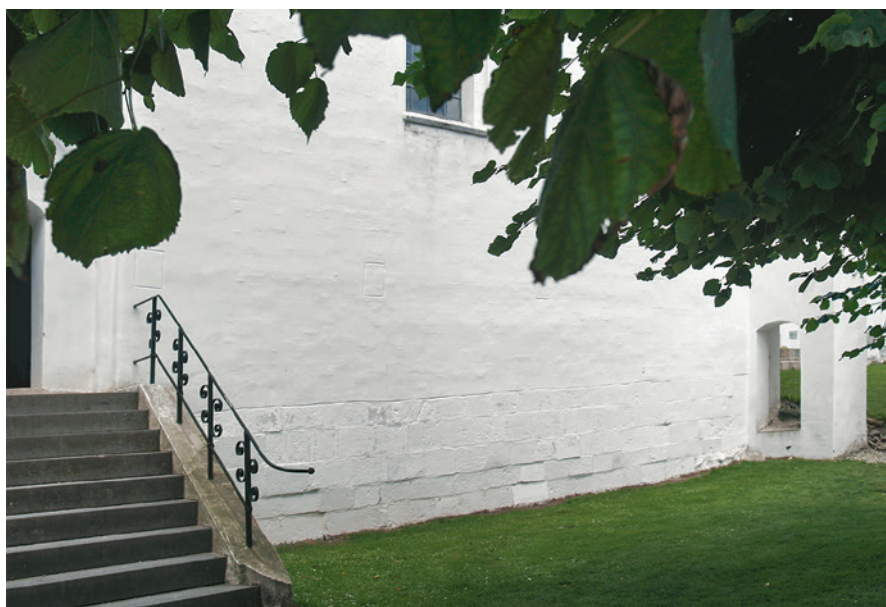
Fig. 11. Søndre sideskib ved domkirken i Børglum. I sideskibsdørens halve højde er der markeret en række tilmurede huller, som er anbragt systematisk. De tolkes som hørende til en træbygget korsgang. Stræbepillen til højre er den sidste rest af søndre korsarm, og døråbningen har i middelalderen formentlig givet adgang fra en korsgang ved østfløjen til selve kirken. – Foto: HKK 2007.
