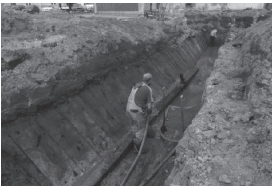
Fig. 6. Palisadens vestlige del, som oprindeligt stod med vand på begge sider, er i tidens løb presset bagover og skråner derfor mere end de oprindelige 15°. Forneiden ses den såkaldte bundrem med rester af pløkker. I baggrunden er palisadens hjørnesamling. Set fra syd. – Foto: Sydsjællands Museum.
