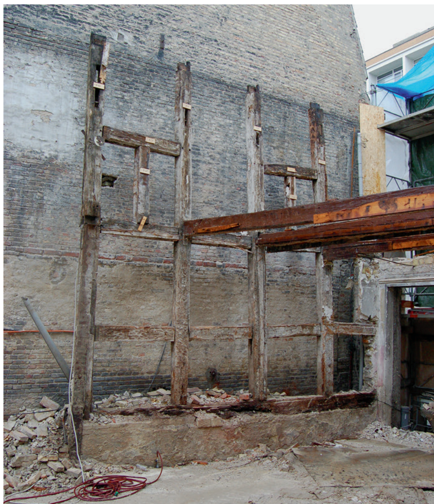
Fig. 27. Fra nedrivningen af hus A100 i 2007. Billedet viser de fire nordligste fag af vestvæggen set inde fra huset.
