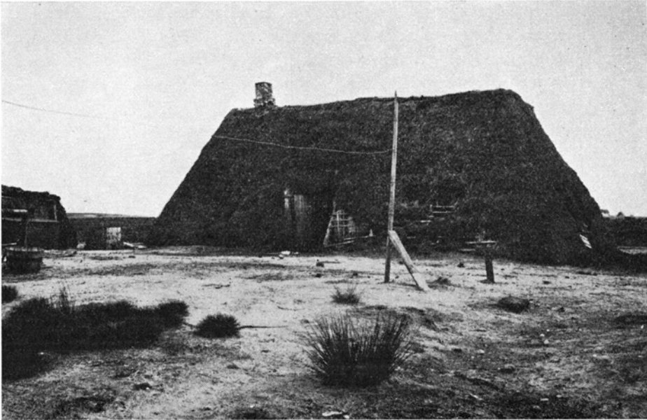
Fig. 13. Spændhus fra Hjortlund ved Sdr. Omme. Huset har tjent som bolig for en tørvearbejder. Netop sådan må — bortset fra skorstenen — Gørdinghuset have set ud.
