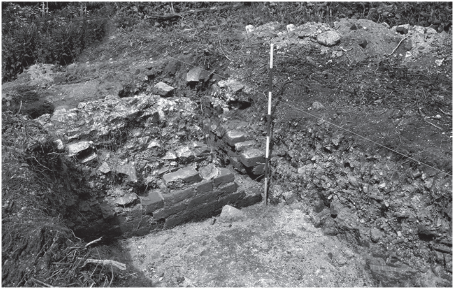
Fig. 17a. Den indvendige side af østfløjens mur mod borggården. Muren har sat sig så meget, at der er opstået et regulært brud. Øverst på midten af den bevarede mur ses resterne af vederlag til kælderens tøndehvælv (se fig. 17b). Kælderens gulv ligger her dybere end den frilagte flade og blev ikke eftersøgt. Set mod nordvest. – Foto: Jan Kock.
