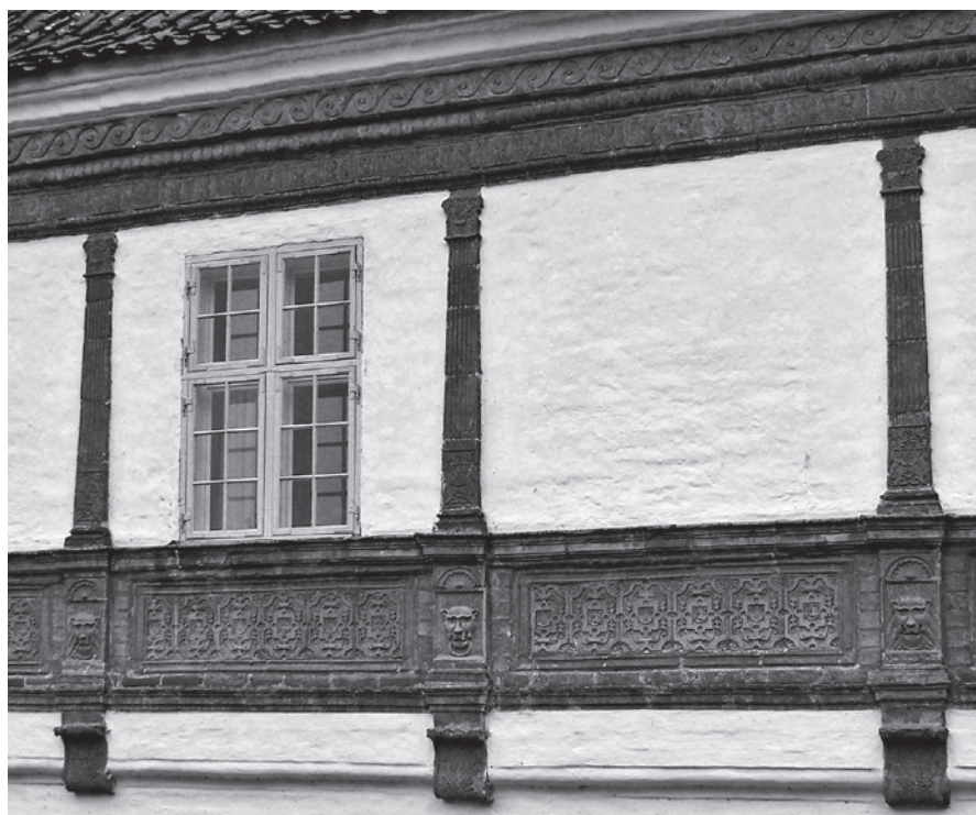
Fig. 20. To fag af terrakottadekoration på første sal af hovedbygningen på den vestjyske herregård Brejninggård. Sådant kan frisen på Skjern også have set ud. Denne slags terrakotta er stærkt inspireret af byggeskikken i Nordtyskland. – Foto: Foto/Medicafdelingen, Moesgård.
