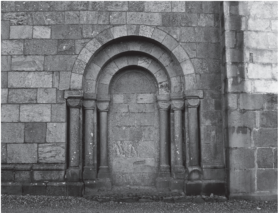
Fig. 14. Nordportalen på Vorning Kirke. – Foto: A.C. Christensen.
