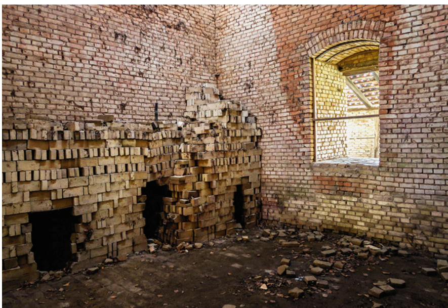
Fig. 11. Ovnrum på Bladstrup Teglværk genopført i Den Fynske Landsby 1957. Til venstre tre indfyringsåbninger, foran hvilke der er opstablinger af tegl fra den sidste brænding. Til højre porten til overovnen, der mures til inden en brænding. – Foto: Eigil Hansen, Museum Odense.
