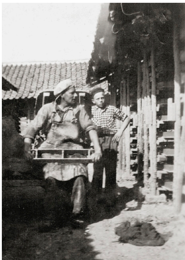
Fig. 27. Teglslageren står til ære for fotografen med en form, der kan rumme to sten. Fotografiet er taget ved et teglværk, hvor manden står mellem et par tørrelader. Bemærk den lette trækonstruktion, og at reolerne står på spinkle fundamenter af teglsten lagt på fladen lig dem, der er påvist i Bregnet. – Foto: Ukendt fotograf, ca. 1950.
