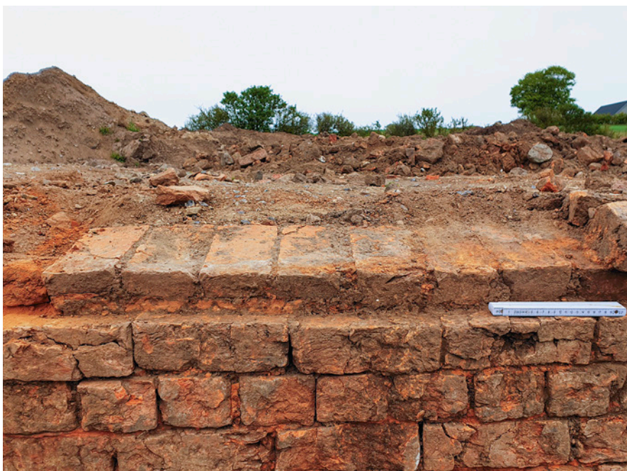
Fig. 35. Rest af tøndehvælvet overdækning på nordsiden af den mindre ovn. – Foto: Museum Østjylland, 2020.
