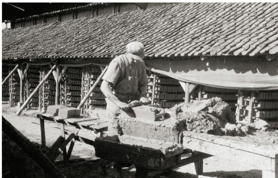
Fig. 25. Teglslageren på teglværket Grønland ved Egersund i færd med at stryge overskudsler af den fyldte form. Her har man valgt en løsning, hvor stenen slås ud af formen på et bræt og derefter lægges til tørring. Det er sten i munkestensformat, der her produceres til en specialordre. Forrest på strygebordet er monteret et vandtrug, hvori formen skylles forud for den næste slagning. I middelalderen foretrak man at bruge sand som slipmiddel i stedet for, som her, vand. I baggrunden ses en tørrelade med sten i nutidigt format. Fotografiet er fra o. 1950. – Foto: C. Jessen, Broagerlands Lokalarliv.
