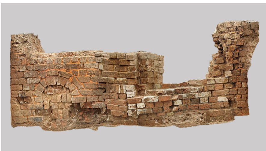
Fig. 36. Inderside af sydmur i ovnkammer på den mindre ovn, set fra nord. Sporene efter den tilførte dør ses tydeligt i murens vestside. – Foto: Museum Østjylland, 2020.
