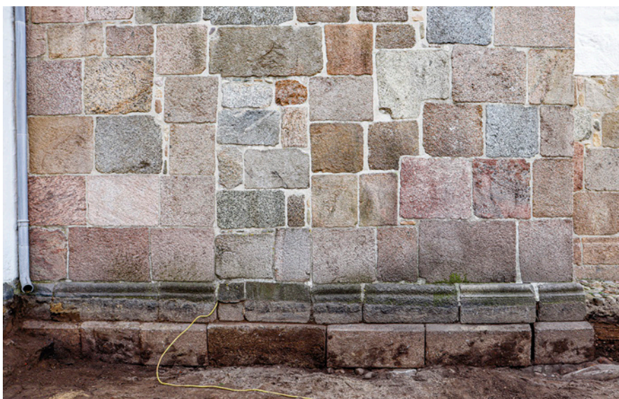
Fig. 3. Den tilmurede dør på skibets nordside. Døren, der er placeret længere mod vest end kirkens egentlige norddør, har givet adgang til det romanske tårnrum. – Foto: H. Mikkelsen, Nationalmuseet, 2022.
