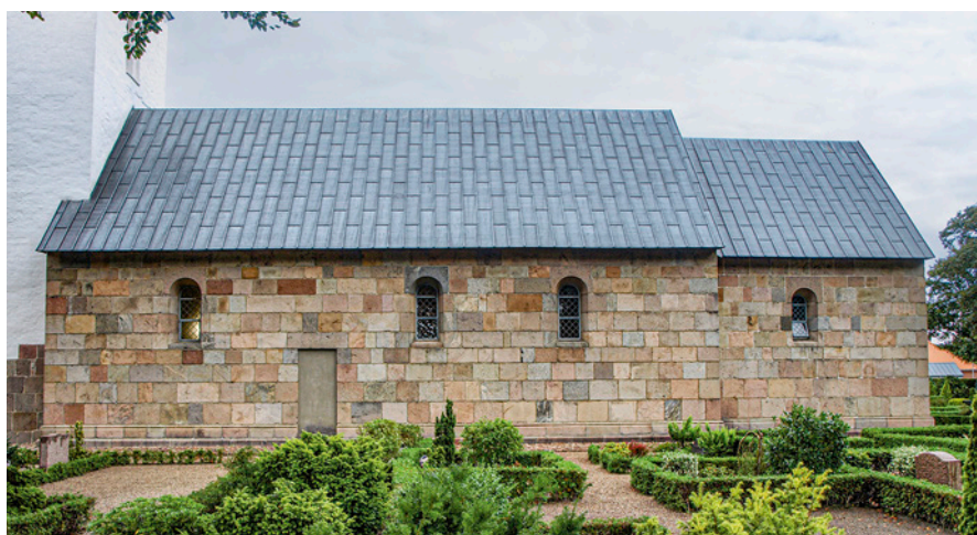
Fig. 2. Kirken i Rindum set fra syd. Det bemærkes, at de romanske bygningsafsnit er rejst over den samme dobbeltsokkel, og at skibets tilmurede syddør er placeret længere mod øst end normalt. – Foto: M. Larsen, Nationalmuseet, 2022.
