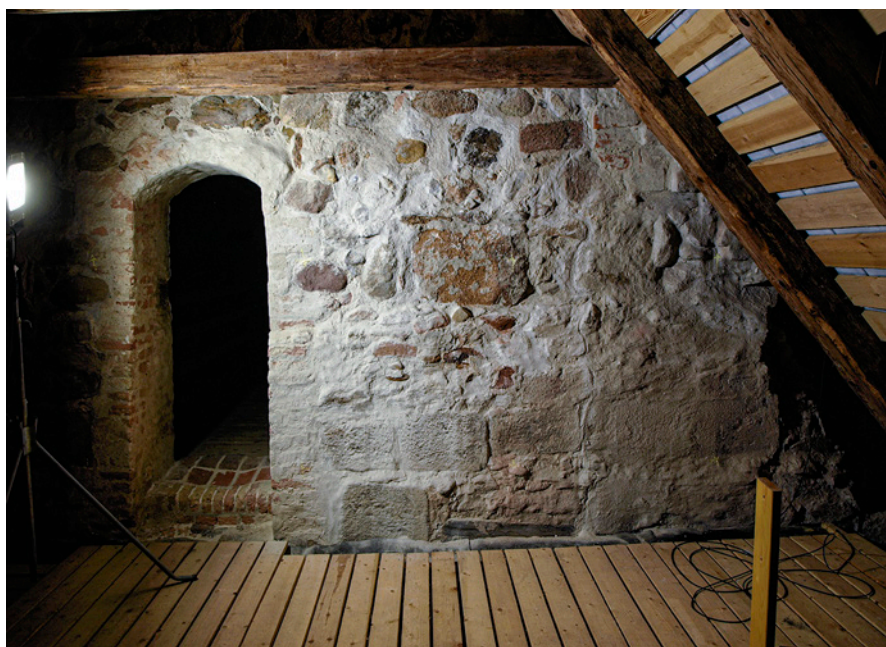
Fig. 6. Østsiden af skibets vestgavl set fra tagrummet. Gavlen rummer spor af de nedrevne rester af kirkens romanske vesttårn. – Foto: M. Larsen, Nationalmuseet, 2022.
