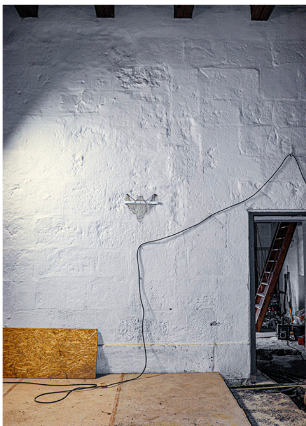
Fig. 5. Skibets nordmur er indvendigt kvadersat, og i vestenden er det tydeligt, at skifterne ikke går op, men derimod markerer en reparation eller omsætning. Iagttagelsen korresponderer med den fundne fundamentsgrøft. – Foto: H. Mikkelsen, Nationalmuseet, 2022.
