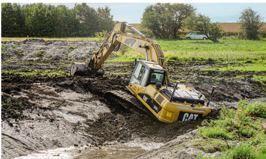
Fig. 3. Som følge af anlægsarbejdet sænkedes vandstanden i Sling 2 med godt 2 meter. I baggrunden ses et stort jorddepot med materiale fra adskillige oldtidsveje. – Foto: B. Madsen, Museum Østjylland.
