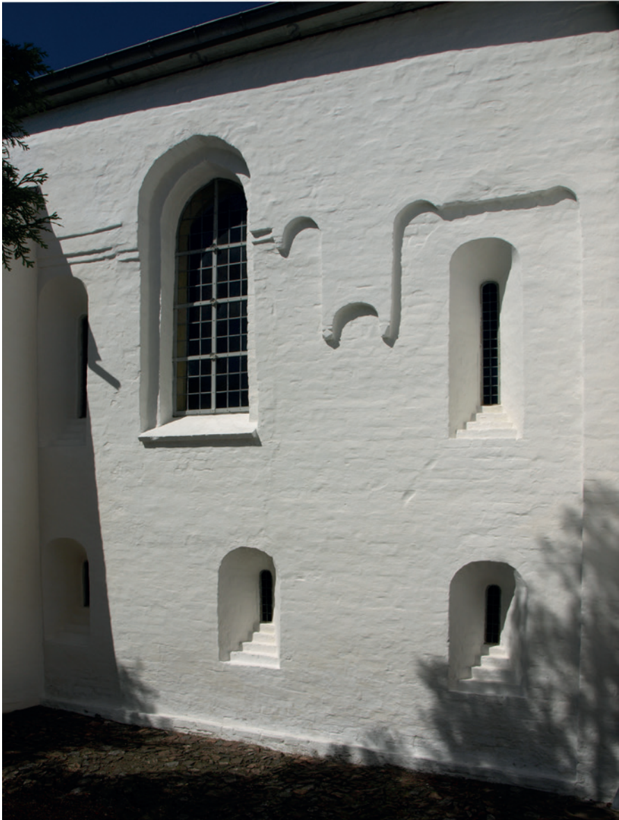
Fig. 6. Skibets sydlige langmur udgøres fortsat af store partier af den ældste senromanske teglstenskirke. Selvom vinduerne i skibets øvre stokværk er udvidet i gotikken, og facaden i dag brydes af stræbepiller fra efterreformatorisk tid, får man endnu fornemmelsen af de senromanske former. – Foto: Morten Larsen 2019.
