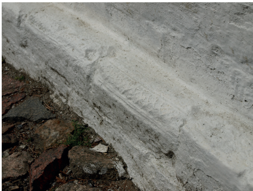
Fig. 7a. Detalje af kirkens senromanske sokkelparti. Til trods for den kraftige kalkpuds er det endnu muligt at iagttage soklens indstemplede ornamentik. – Foto: Morten Larsen 2019.
