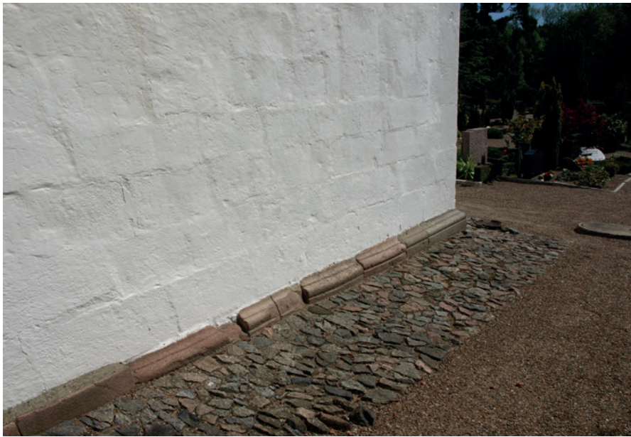
Fig. 11. Vestsiden af søndre korsarm. Der er ved opførelsen benyttet store mængder af genanvendte kvadersten, herunder enkelte afrundede, der oprindeligt har været anvendt i en apsis. Stenene er formentligt hentet fra den nærliggende kvaderstenskirke i Torup, blot få kilometer fra klostret, der blev nedbrudt i senmiddelalderen. – Foto: Morten Larsen 2020.
