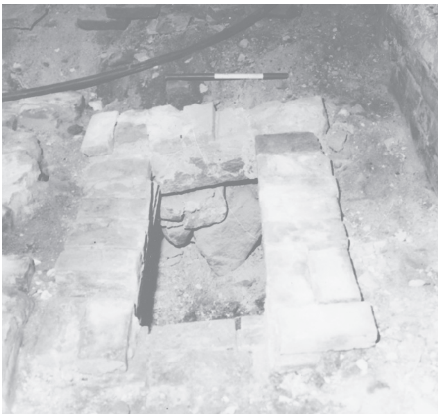
Fig. 18. Vestfløjens kanal set fra syd. Ved undersøgelsen i 1984 blev kanalen berørt. Som man kan ane, var den ældste del kendetegnet ved kampestenssatte sider (hvilket kan anes), der i renæssancen havde fået en overbygning i teglsten. – Foto: Vendsyssel Historiske Museum 1984.
