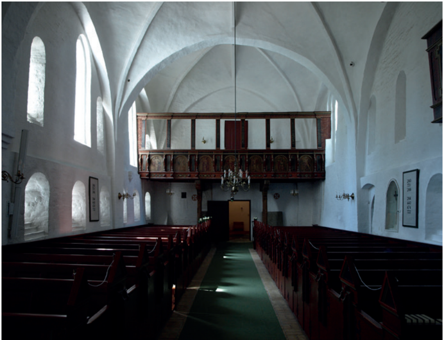
Fig. 9. Det indre af kirkens skib set fra øst. På begge langmure ses et tilbagespring, der markerer skibets oprindelige opdeling i to stokværk. Overhvælvingen er senmiddelalderlig, og det oprindelige senromanske kirkerum har været mere lavloftet sandsynligvis med træloft. – Foto: Morten Larsen 2020.
