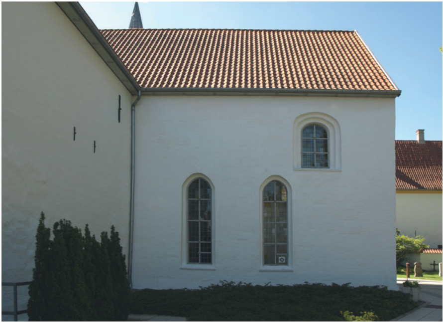
Fig. 13. Østsiden af nordre korsarm. Til venstre ses to lavtsiddende vinduer, der er indsat i efterreformatorisk tid. Til højre ses et oprindeligt, senmiddelalderligt rundbuet vindue. Det middelalderlige vindue har oprindeligt haft sålbænken placeret i et væsentligt lavere niveau, men i kraft af de mange ombygninger af korsarmen i nyere tid er sporene af dette få og svære at konstatere. – Foto: Morten Larsen 2020.
