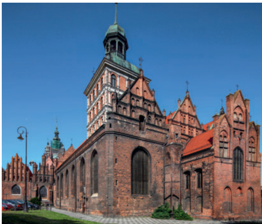
Fig. 38. Marienbrunn Klosterkirke i Danzig set fra sydøst. Som det var karakteristisk for mange af 1300-tallets nordtyske kirker, er stræbepillerne placeret indvendig, således at der er mulighed for en glat ydre væg. Udbygningen mod øst er det gamle Magdalena Kapel. Det var etableret for tidligere prostituerede, og her hvilede de jordiske rester af Den Hellige Birgitta undervejs fra Rom til Vadstena. I baggrunden ses Sankt Katharine Kirke, som havde afstået jord til birgittinerklostret. – Foto: Christofer Herrmann 2010.
