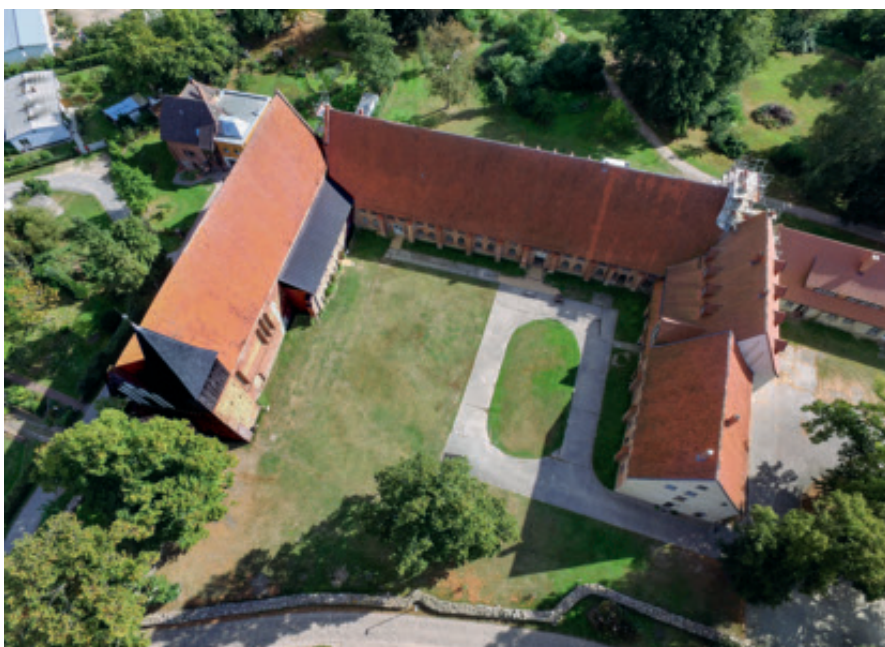
Fig. 25. Cisterciensernonnekloster Rühn set mod øst fra luften. Den langstrakte (45 m) og enskibede kirke (til venstre) og de øvrige bevarede klosterbygninger stammer fra midten af 1200-tallet. Formentlig har klostergården aldrig været lukket. Korsgangen langs kirken førte fra nonnernes dormitorium i østfløjen frem til det 25 m lange nonnepulpitur i kirkens vestende. – Foto: Wikimedia Commons 2016.
