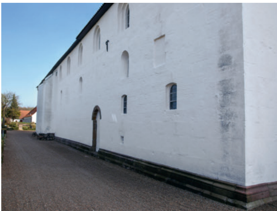
Fig. 8. Den romanske dobbeltsokkel, der kendetegnede kirkens skib, er endnu synlig på bygningens nordside. Korpartiet var derimod rejst over en sokkel med omvendt faldende karnis. – Foto: PKL 2013.
