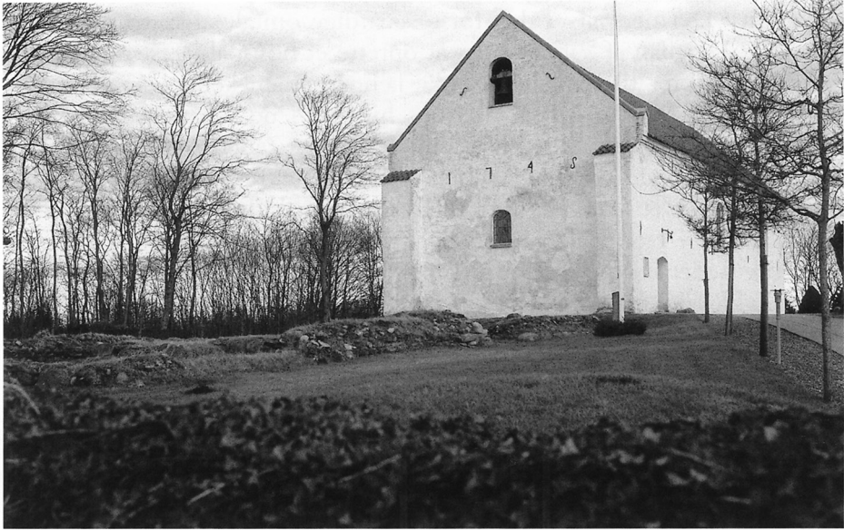
Fig. 2. Testrup kirke som den tager sig ud i dag med ruinen af hospitalsbygningen ved vestenden. På kirkens vestgavl ses årstallet 1748, som antages at være det år, hvor kirkens vestende og muligvis også hospitalet blev revet ned. Foto: Betty Laustsen.
