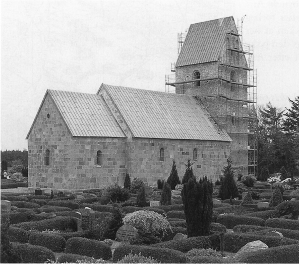
Fig. 38. Sønders Nisum kirke er typisk vestjysk med sin romanske bygningskerne opført af tilhugne granitkvadre. Tårnet kom til i senmiddelalderen. Fra romansk tid er kirkens alterbord og døbefont bevaret. På alterbordet står en fin fløjaltertavle fra 1587. Foto: Jørgen Borg.
