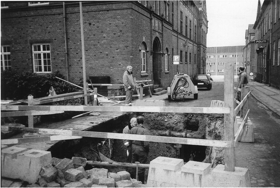
Fig. 2. Forud for de lange kloakgravninger udlagde museet en række prøvegravninger. På hjørnet af Rådhusgade/Søndergade skulle prøvegravningen opnå kontakt med byens grav og datere eventuel bebyggelse. Foto: Horsens Museum.
