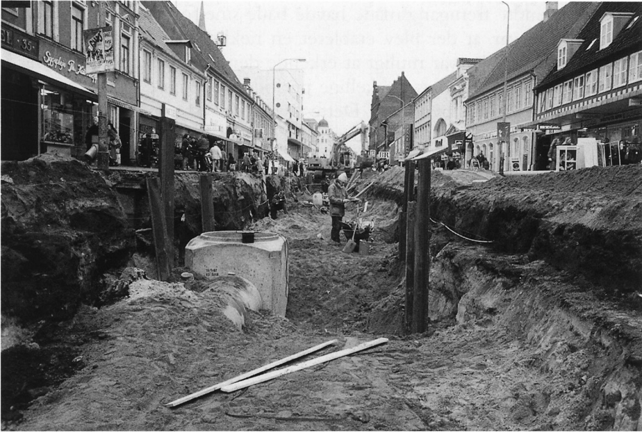
Fig. 3. Udgravningerne foregik under store vanskeligheder. Foto fra Søndergade, hvor kloakgrøften er gravet og igen opfyldt, før arkæologerne begynder dokumentationen af kulturlagene i grøftens sider. Foto: Horsens Museum.
