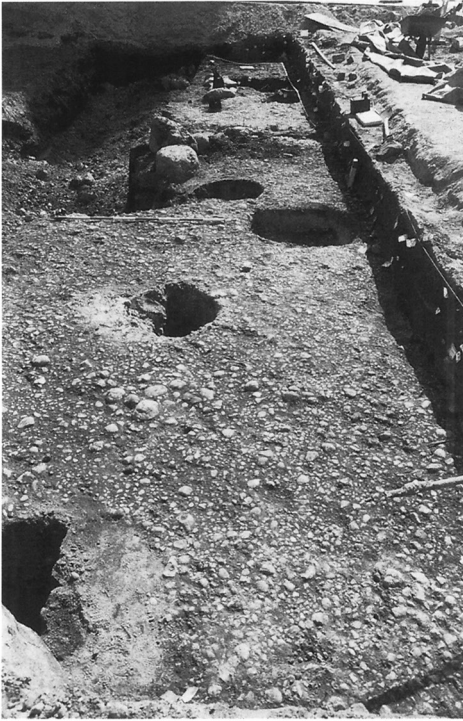
Fig. 14. Overalt i den "nye" by blev brolægninger af denne art udlagt i gaderne og på Torvet i tiden omkring 1300. Brolægningen lå placeret på undergrundssand, efter at ældre kulturlag eller det oprindelige vækstlag var bortgravet. Foto: Horsens Museum.
