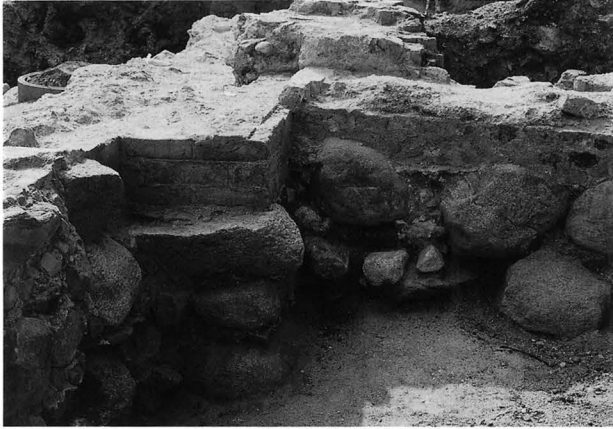
Fig. 9. Den vestligste stræbepille på hospitalsbygningen og den nordre tilbygning set fra øst. Det ses tydeligt, at tilbygningen er en senere tilføjelse, hvis fundering ligger højere end hospitalsbygningen fra 1495. Måske er tilbygningen først opført efter reformationen. Foto: HKK 1995.
