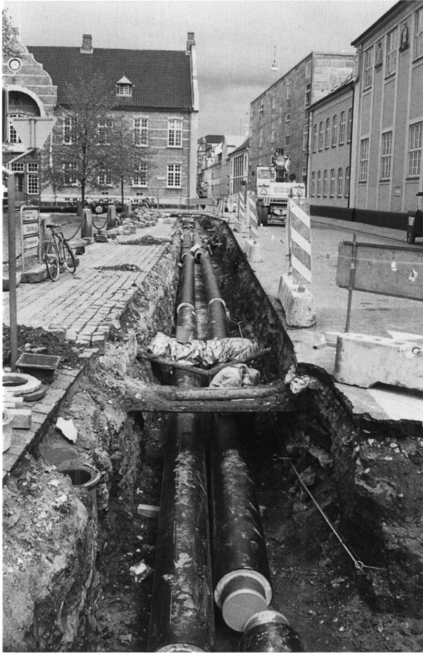
Fig. 3. Fjernvarmegroften i Skolegade set fra syd hen imod Kvindemuseet. I profilvæggen til højre kunne resterne af den middelalderlige kirkegårdsmur følges. Foto: Hans Skov.
