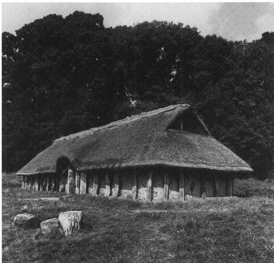
Fig. 14: Toftinghuset som det tager sig ud nu – 9 år efter opførelsen. The Tofting house today – 9 years after erection.
