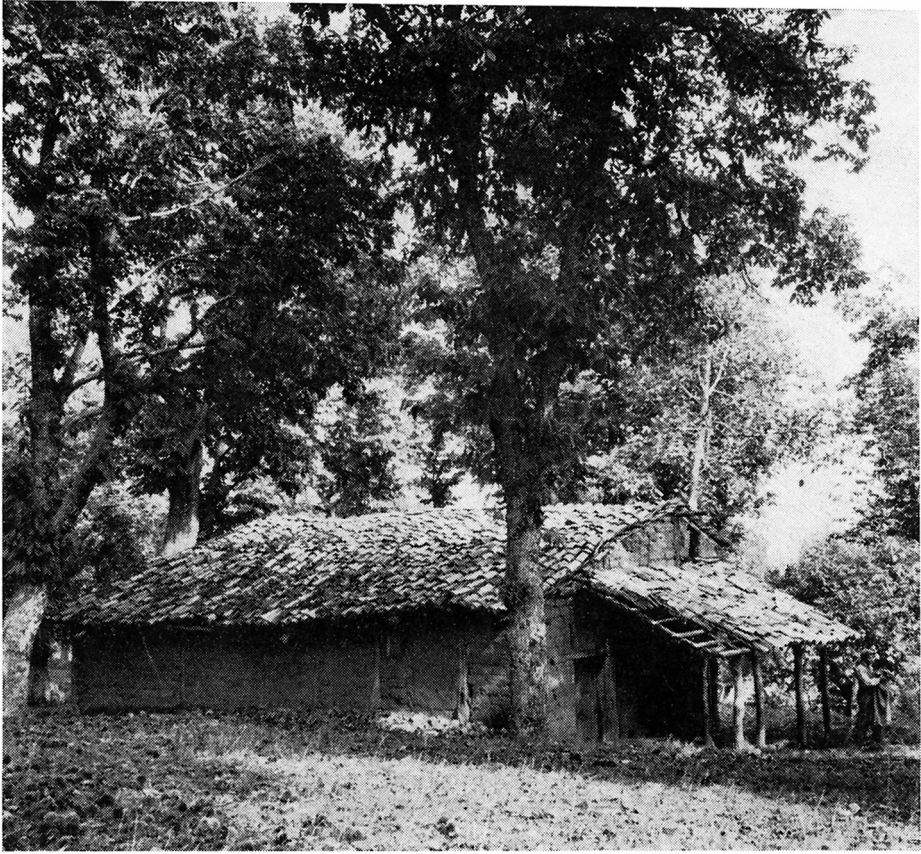
Fig. 11. Kastanietørrehus, seccatoio , i udkanten af San Martino. Bemærk væggenes bindingsværk og tagåsen.
