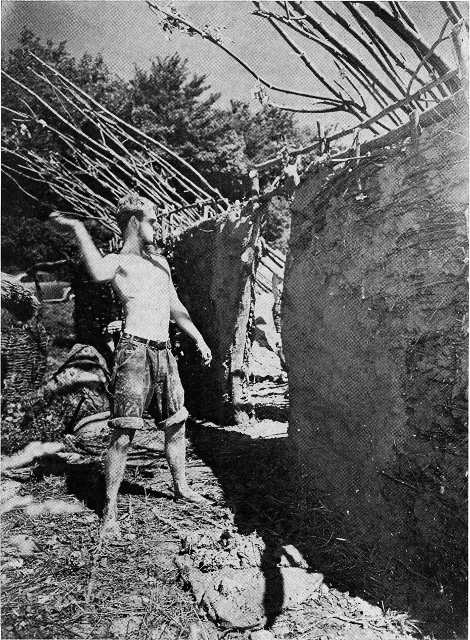
Fig. 3. Det samme vægparti, som vist i fig. 6 og 7, under klining. Man får et indtryk af de store lermængder, der er tale om, og som risfletning og vægstolper skal bære.
