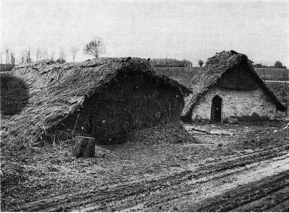
Fig. 1 a. Lerhusene ved Allerslev. The mud-houses at Allerslev.
