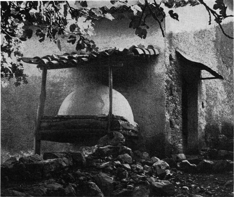
Fig. 3. San Martino. Fremspringende bagerovn på bjælkeunderlag. HR fot. 1953. San Martino. Lean-to baking oven on plank base.
