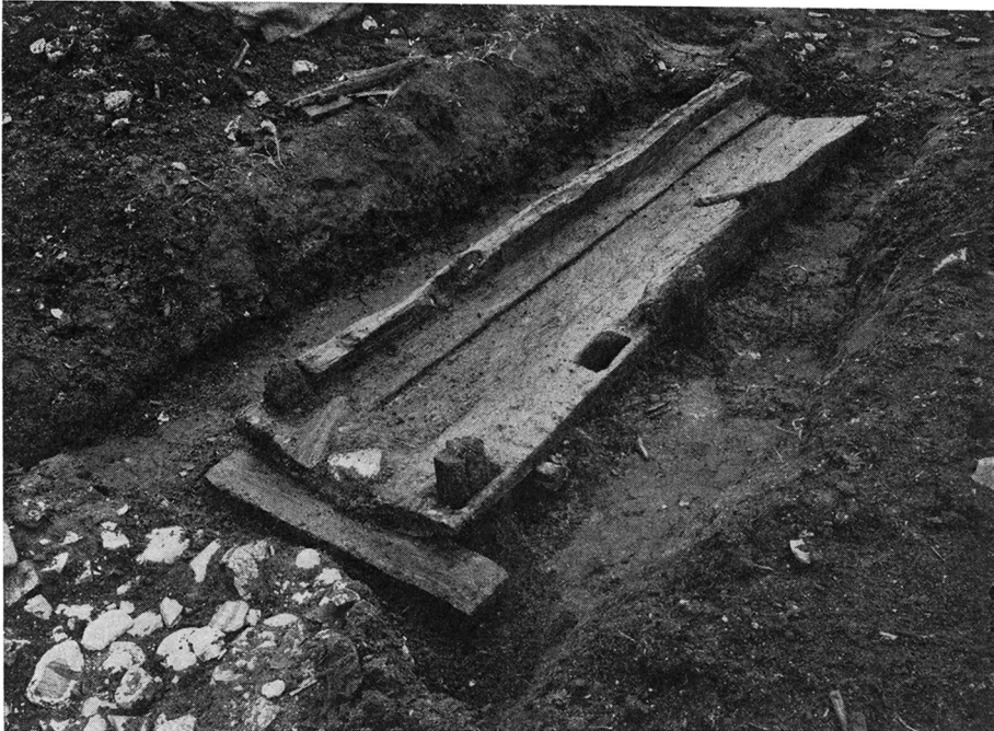
Fig. 5. Trærende i bulkonstruktion. Wooden channel of fitted-log ("bul") construction.
