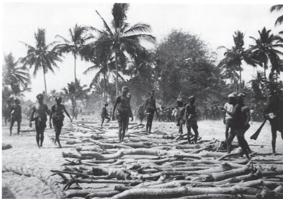
Fig. 4. For at lette trækningen af en gravsten, er der lagt træ ud på tværs, så slæden med stenen ikke synker ned i det løse sand. Sumba 1931. – Foto: L.C. Heyting.
