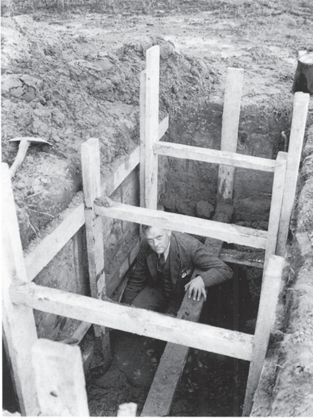
Fig. 7. Den altid nobelt klædte Erik Westerby i forsvarligt afstivet sondage-gravning i søaflejringer på Bromme-bopladsen, september 1949. – Foto: Erik Westerby. Nationalmuseet.
