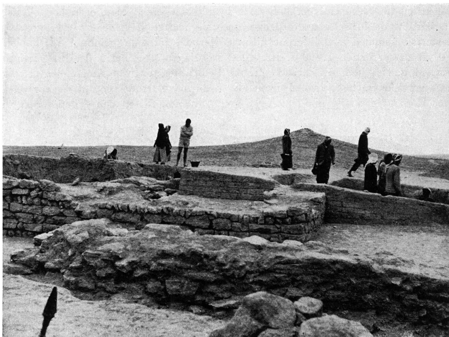
Fig. 11. Største delen af bastionen, frigrauet. I forgrunden grov fodmur af kalksten. Til højre den lave stenrampe. I midten nord- og vestmurens hjørne. Bag dette den indre rampe og mur af soltørrede lersten. En lignende til højre. Set fra nordnordvest.
