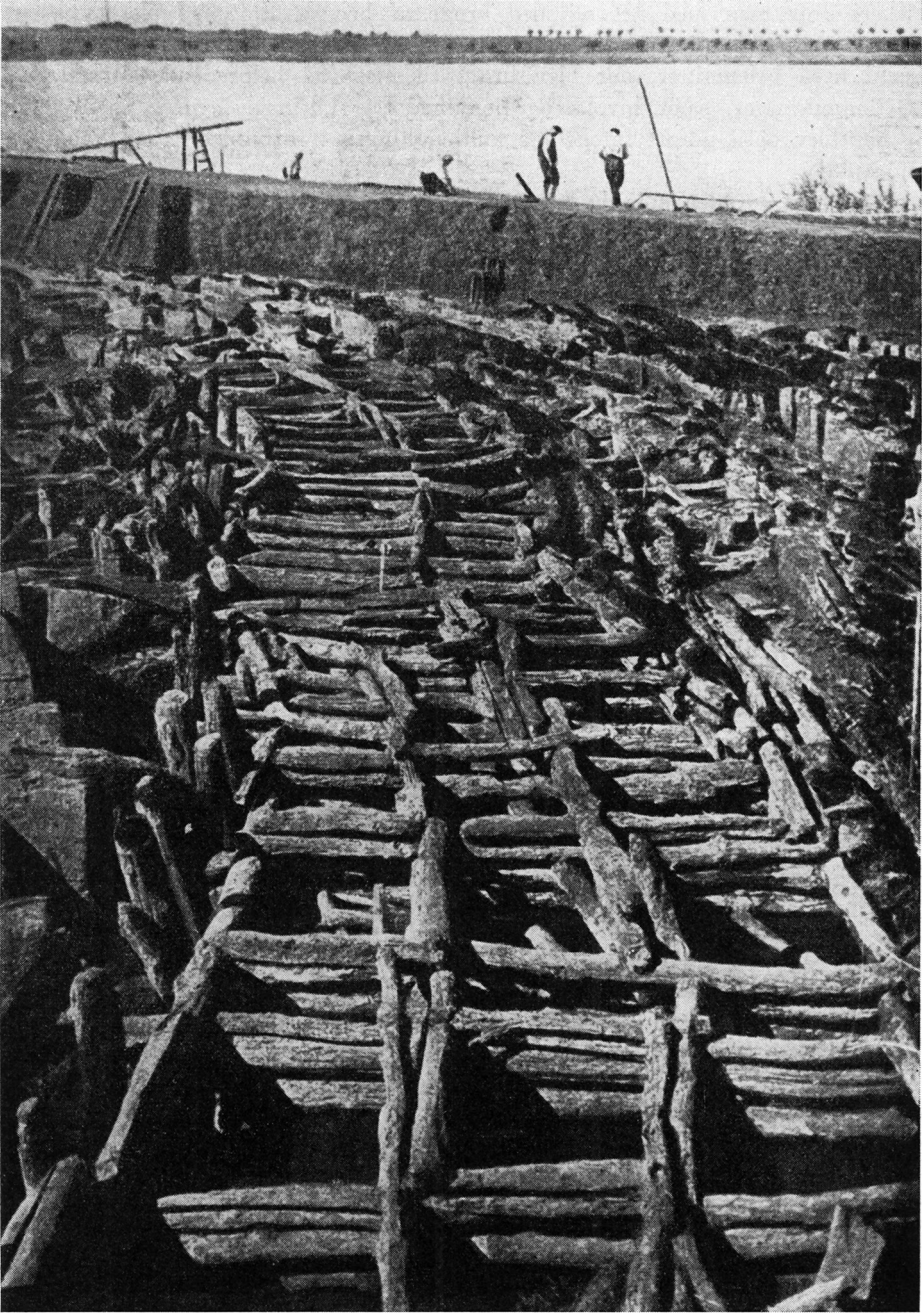
Fig. 16. Den kassekonstruerede træmur, der har omgivet hele byen. Die Konstruktion der Holzmauer.
