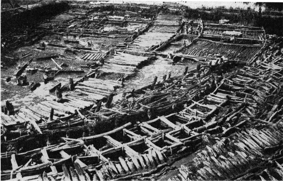
Fig. 17. Udblik over en kvadrant af det udgravede område i Biskupin. Fra forgrund til baggrund: Bølgebryder, trævold, gader og husanlæg.
