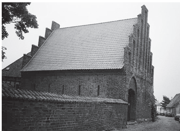
Fig. 18. Kalundborg kirkelade. Sydgavlen med porten ud mod Præstegade. Bemærk de rekonstruerede gavlblændinger og gluggerne på vestmuren. – Foto: Morten Kjølnør Petersen.
