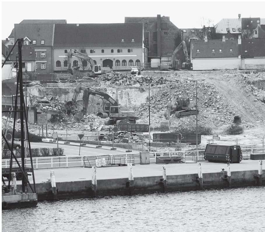
Figur 2: Solofabrikken er nedrevet, og grunden ryddes til boligbyggeri. (Foto: Henrik Reeh)
