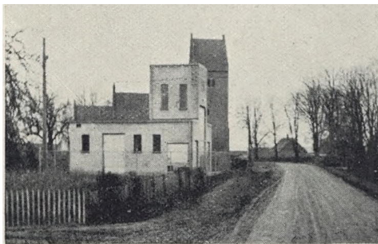
Fig. 107. Majbølle, Musse Herred, Ny Bebyggelse ved Kirken (Transfor- matorstation).
