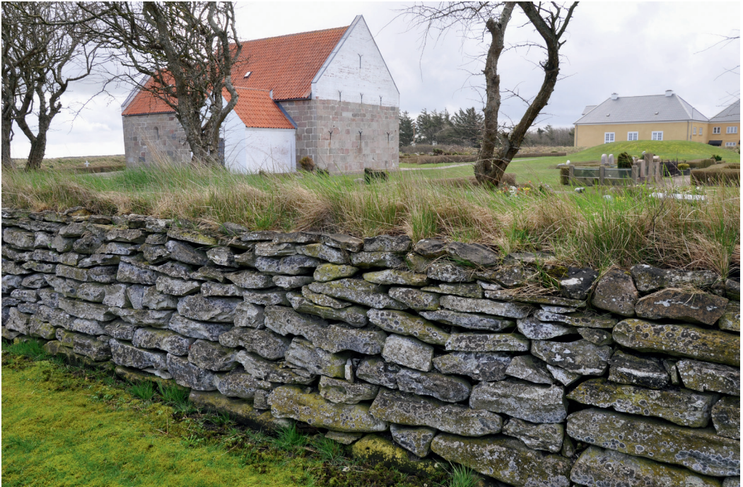
Fig. 6. Dige opført af brudte, tildannede kalksten. Norddiget, Hansted Kirkegård. Foto: Mogens Bjørn Andersen.
