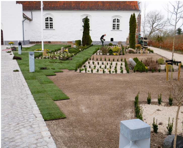
Udlægning af rullegræs. Illustration fra bogen. Foto: Anders Beck Larsen.
