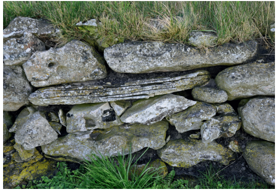
Fig. 5. Kalkstenen frostsprænges og flækker i aflejringslagene. Foto: Mogens Bjørn Andersen.
